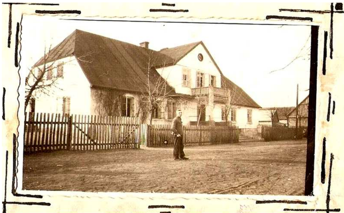
Budynek szkoły i urzędu gminy w Piekarach z 1919 r.
